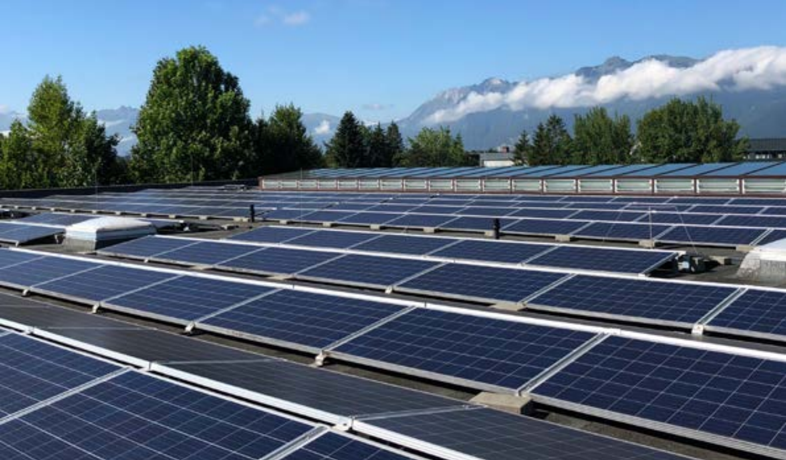
Die 360 Photovoltaik-Paneele mit 93,6 kWp könnten pro Jahr mehr als 22 Vier-Personen-Haushalte mit Strom versorgen.
